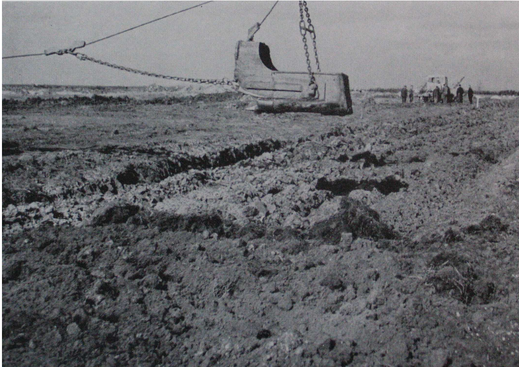
Figuur 2.8 Egalisatiewerkzaamheden tijdens de herverkaveling van Schouwen-Duiveland
